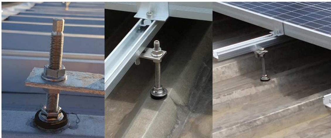
Figura 11: Parafusos estruturais fixados em telha sanduiche.
